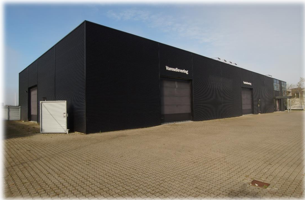
Ejendommen set fra syd-øst
